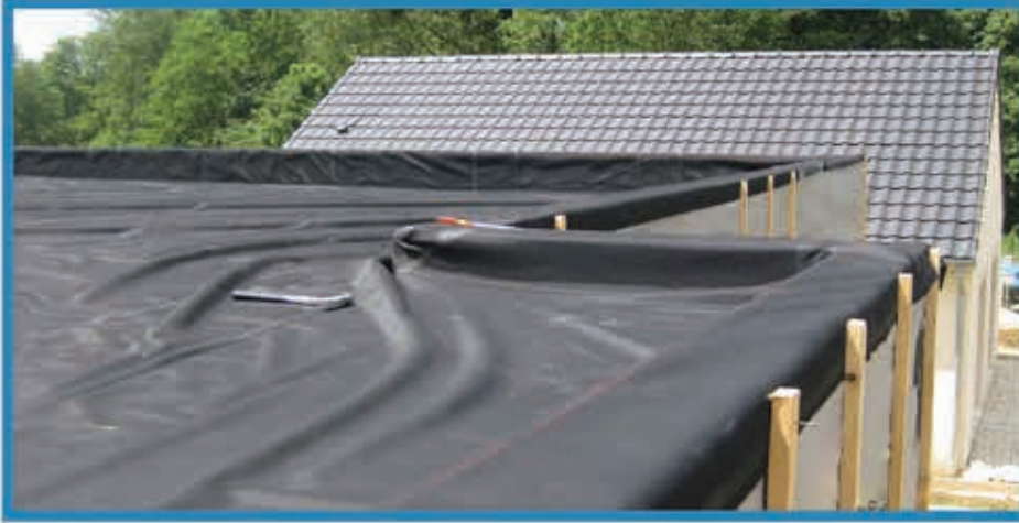
Geotekstil Keçeli EPDM Membran Uygulaması
